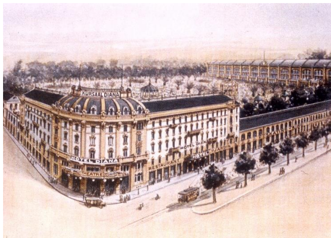
Veduta generale dello stabilimento
